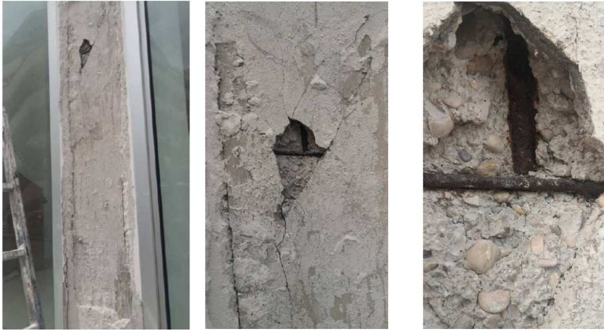
Immagine del saggio effettuato sul pilastro n.5
